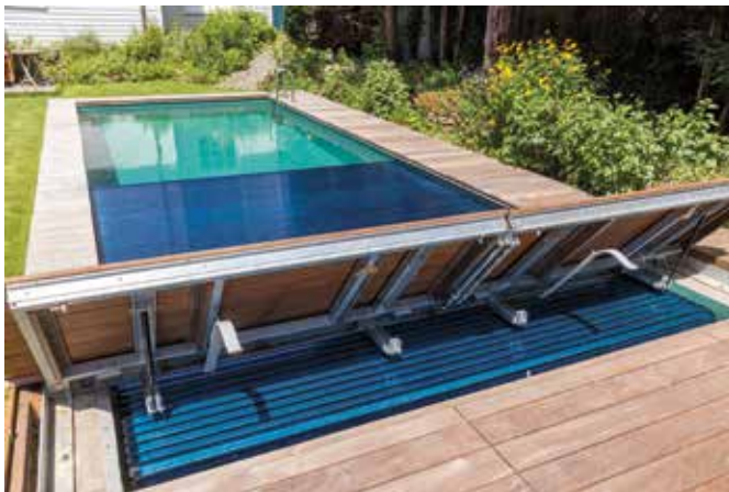
Selbst konstruiert: Die Versorgungsklappen hat Friedrich Martin gemeinsam mit dem Poolbauer entwickelt.
